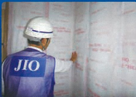
断熱材施工時
